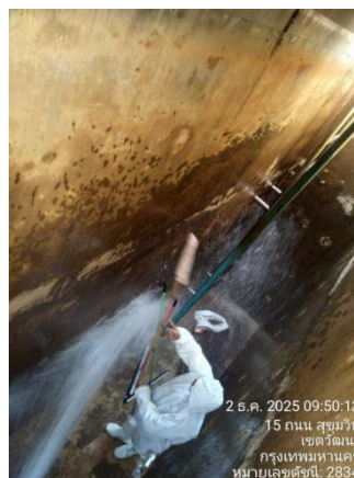
รูปที่ 2-37 การล้างถังสำรองน้ำชั้นดาดฟ้าและชั้นใต้ดิน
